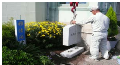
碑の据え付け工事
